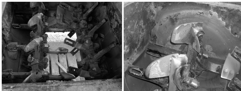
Slika 8. Izgled unutrašnjosti mešalice za proizvodnju asfalta sa rasporedom lopatica
